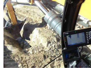
Halbautomatische Aushubarbeiten; Positionierung von Fundamenten, Wänden, Haustechnikinstallationen
